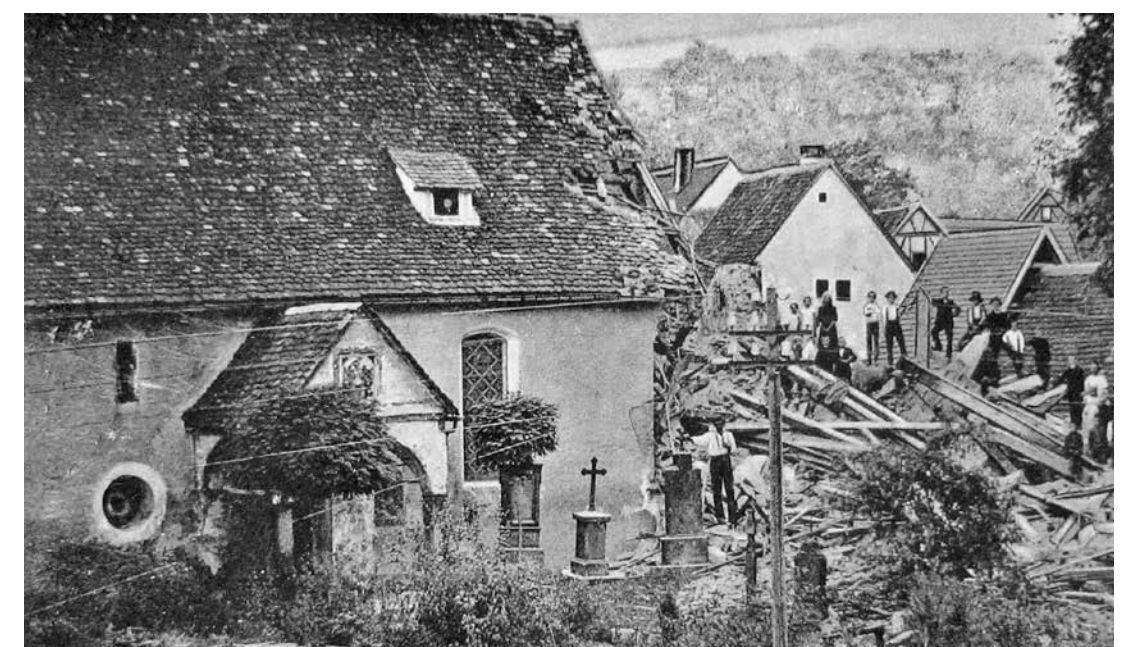
Trümmer des am 14. August 1909 eingestürzten Kirchturms in Nenningen
