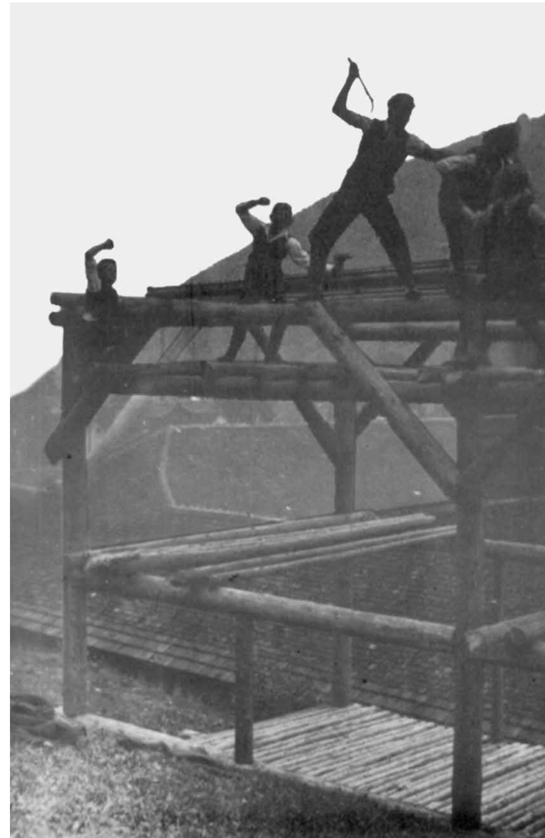
Aufbau des Holzgerüsts zur Eisgewinnung für die Weißensteiner Brauerei etwa 1929
